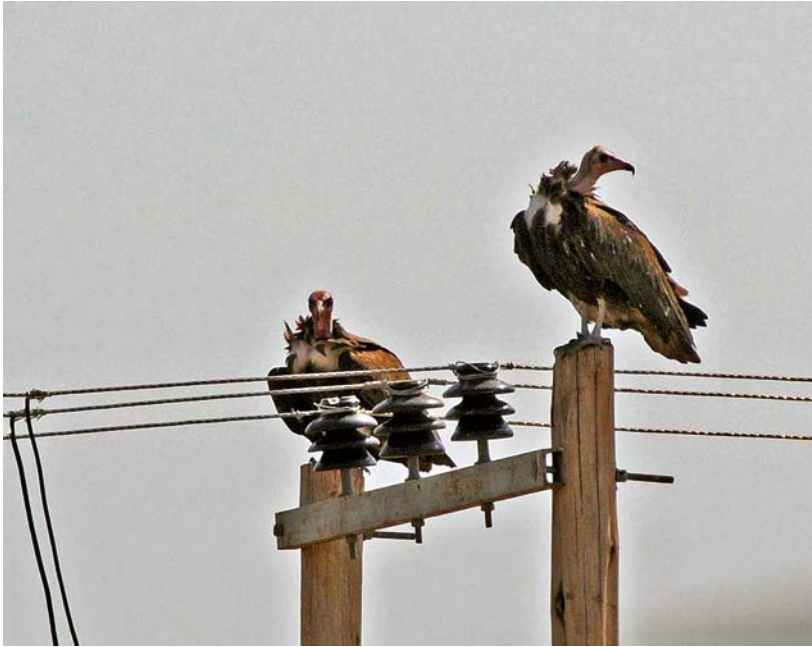
Abb. 12: Kappengeier Necrosyrtes monachus (Länge 60 cm, Spannweite 158 cm) an nicht isolierter Mittelspannungsleitung mit sehr kurzen Phasenabständen. Äthiopien Dezember 2010. – Hooded Vultures Necrosyrtes monachus (length 60 cm, wingspan 158 cm) perching on wooden masts of a medium-voltage powerline with very narrow spacing of uninsulated conductors. Ethiopia, December 2010. Foto: D.G. Haas
