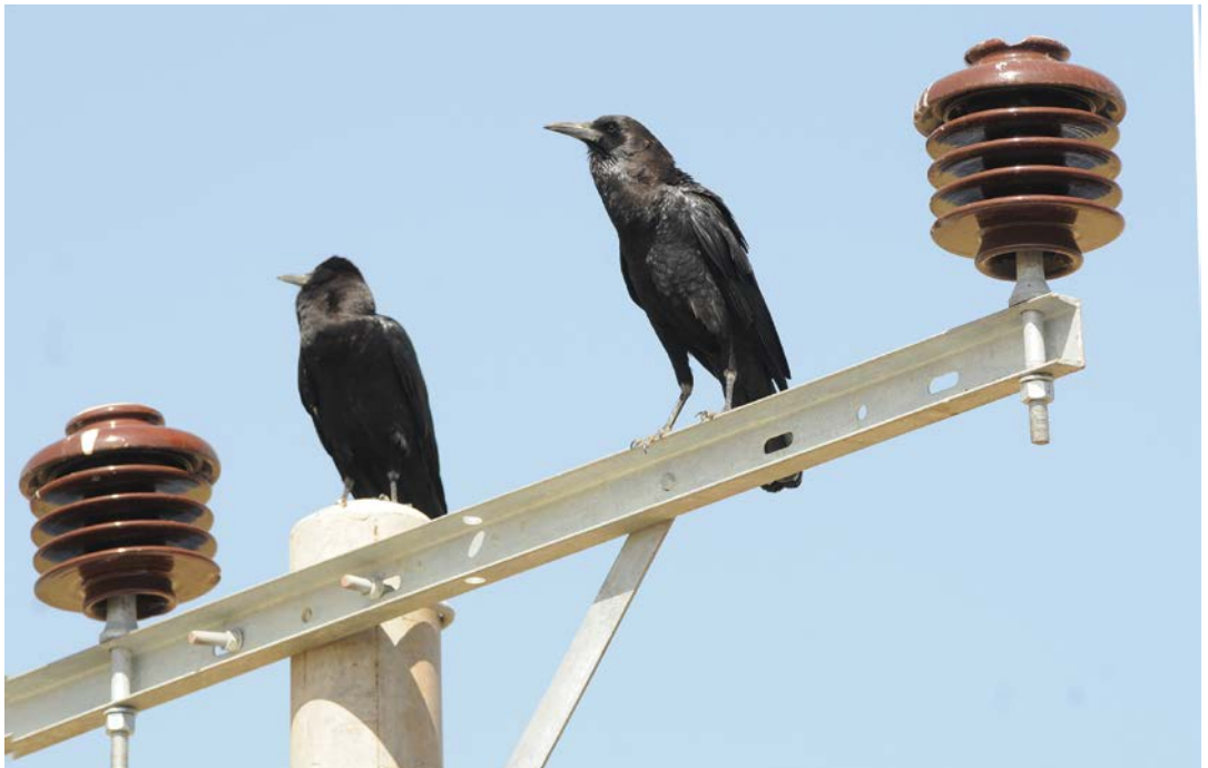
Abb. 1: Kapkrähe Corvus capensis (Länge 43 cm). Balzendes Paar auf Mast aus leitendem Material (Spannbeton) mit Stützisolatoren, vor Anbringung der nicht isolierten Stromleiter. Später ist der Aufenthalt auf solchen Masten dann schon für so kleine Vögel oft tödlich. Sie werden im Folgenden daher als „Killermasten“ bezeichnet. Äthiopien Dezember 2010. – Cape Rook Corvus capensis (length 43 cm). A courtship couple on a „mast“ (pylon, pole) of pre-stressed concrete, a conducting material. The uninsulated conductors are to be attached later. Small birds can easily be killed on such masts, and larger birds cannot land safely. In the following texts, such extremely dangerous structures are referred to as 'killer masts'. Ethiopia December 2010. Foto: D. G. Haas
