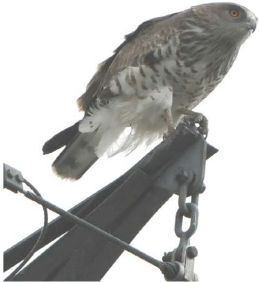
Abb. 21: Schlangennadler Circaetus gallicus (Länge 65 cm, Spannweite 175 cm), sicher über dem Nullleiter (der nicht unter Spannung steht) einer Hochspannungsleitung rastend. Alle 6 Schlangennadlerarten Ostafrikas (davon der Schlangennadler nur seltener Wintergast) rasten gerne auf Freileitungsmasten und werden häufig durch Stromschlag getötet. – Short-toed Snake-Eagle Circaetus gallicus (length 65 cm, wingspan 175 cm), on a safe perch over the neutral conductor (which is not electrified) on the tower of a high-tension powerline. All six species of Snake Eagles in East Africa (the Short-toed Snake-Eagle being only a rare winter-visitor) enjoy perching on masts and towers of power-lines and are often electrocuted. Foto D. G. Haas
