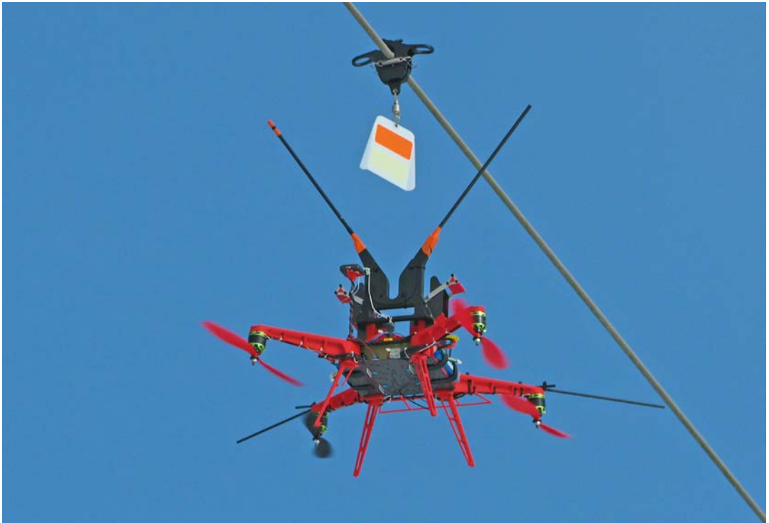
Abb. 39: Um Kollisionsverlusten an Freileitungen entgegenzuwirken, können zur besseren Sichtbarkeit für Vögel erprobte Markierungen angebracht werden. Diese können wie hier gezeigt kostensparend mit Hilfe von Drohnen auch an die unter Spannung stehenden Leitungen angebracht werden. März 2018 Deutschland. – To avoid bird losses through collisions with conductors of powerlines, the visibility of the conductors can be enhanced by fitting markers. These markers can also be attached using aerial drones while the powerlines remain live. March 2018, Germany.
