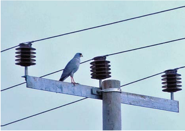
Abb. 2: Weißbürzel-Singhabicht Melierax poliopterus (Länge 50 cm, Spannweite 103 cm). Altvogel, auf Killermast geerdet sitzend (Mast aus Spannbeton, Traverse aus Metall) unmittelbar neben nicht isolierten Leitungsdrähten. Kenia, Januar 2011. – Eastern Chanting Goshawk Melierax poliopterus (length 50 cm, wingspan 103 cm). An adult bird perching on a killer mast (mast of pre-stressed concrete, with metal traverse) directly beneath uninsulated conductors. Kenya, January 2011. Foto: D.G. Haas
