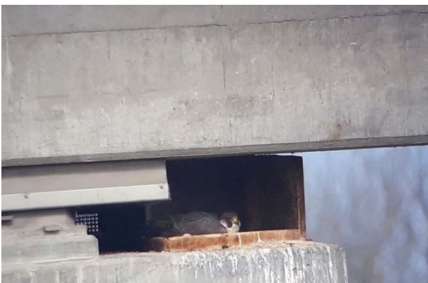
Abb. 1: Brut an der Körschtalbrücke 2018 (Foto: J. Becht)
