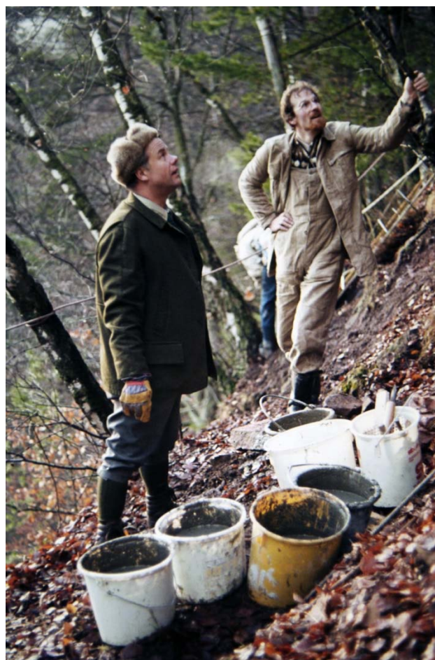
Karlfried Hepp bei Horstbauarbeiten am Unteren Neckar, 1982 (Archiv AGW)
