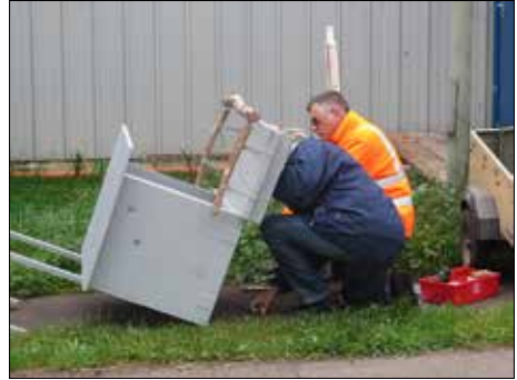
Abtransport, Sanierung und Rücktransport des Mettnicher Kastens, Fotos: Marion Geib
