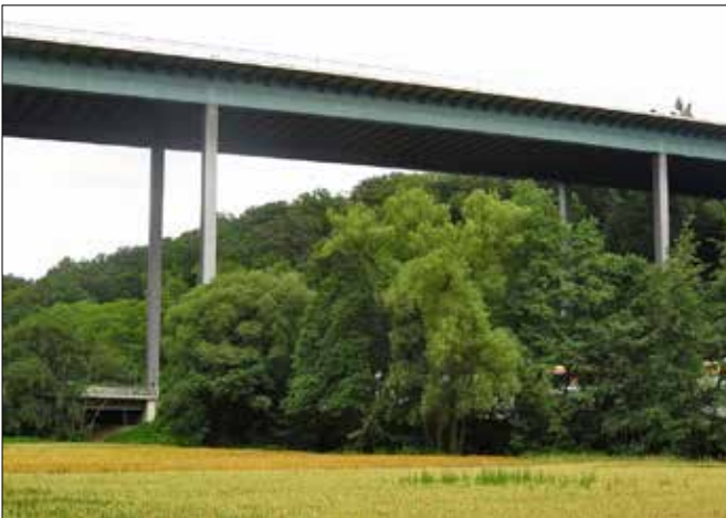
Talbrücke über die A6 in Fechingen, Foto: Marion Geib
