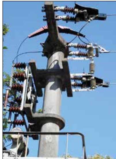
Abbildung 1: Unter diesem Trafomast wurde ein Junguhu tot aufgefunden, Juli 2015. Foto: CHRISTIAN HARMS
